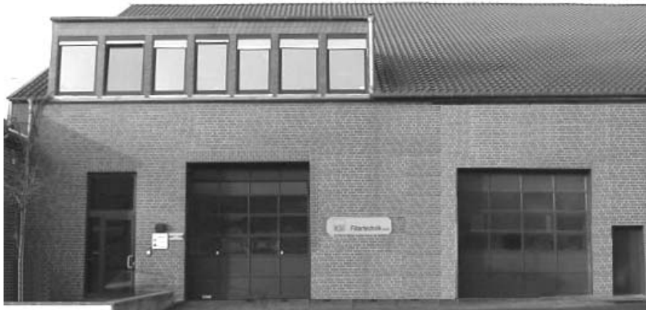
KSI Filtertechnik GmbH - Niederkrüchten
